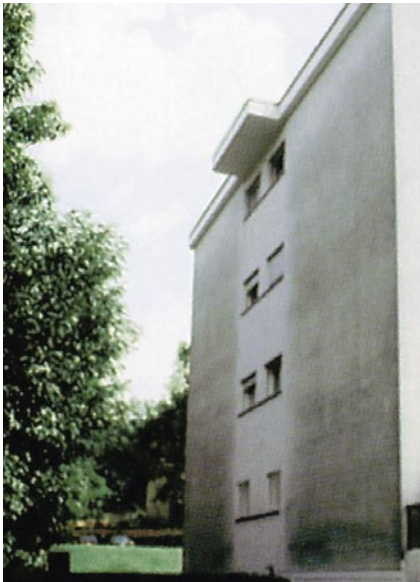
(Abb. 14) Auskragendes Vordach schützt vor Feuchtigkeit
