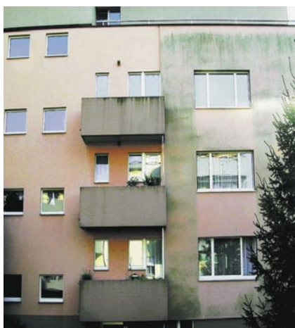
(Abb. 5) Bild Empa St. Gallen
