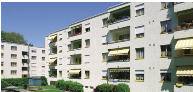
MFH's, Arbon (TG) saniert 1998 mit CALSILIT Fassadenfarbe Algizid und NOVALITH Fassadenfarbe Algizid
