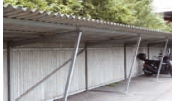
Fassaden/Dächer aus Asbestzement Velounterstände, Gebäudefassaden usw.
