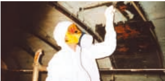
Asbestsanierung
